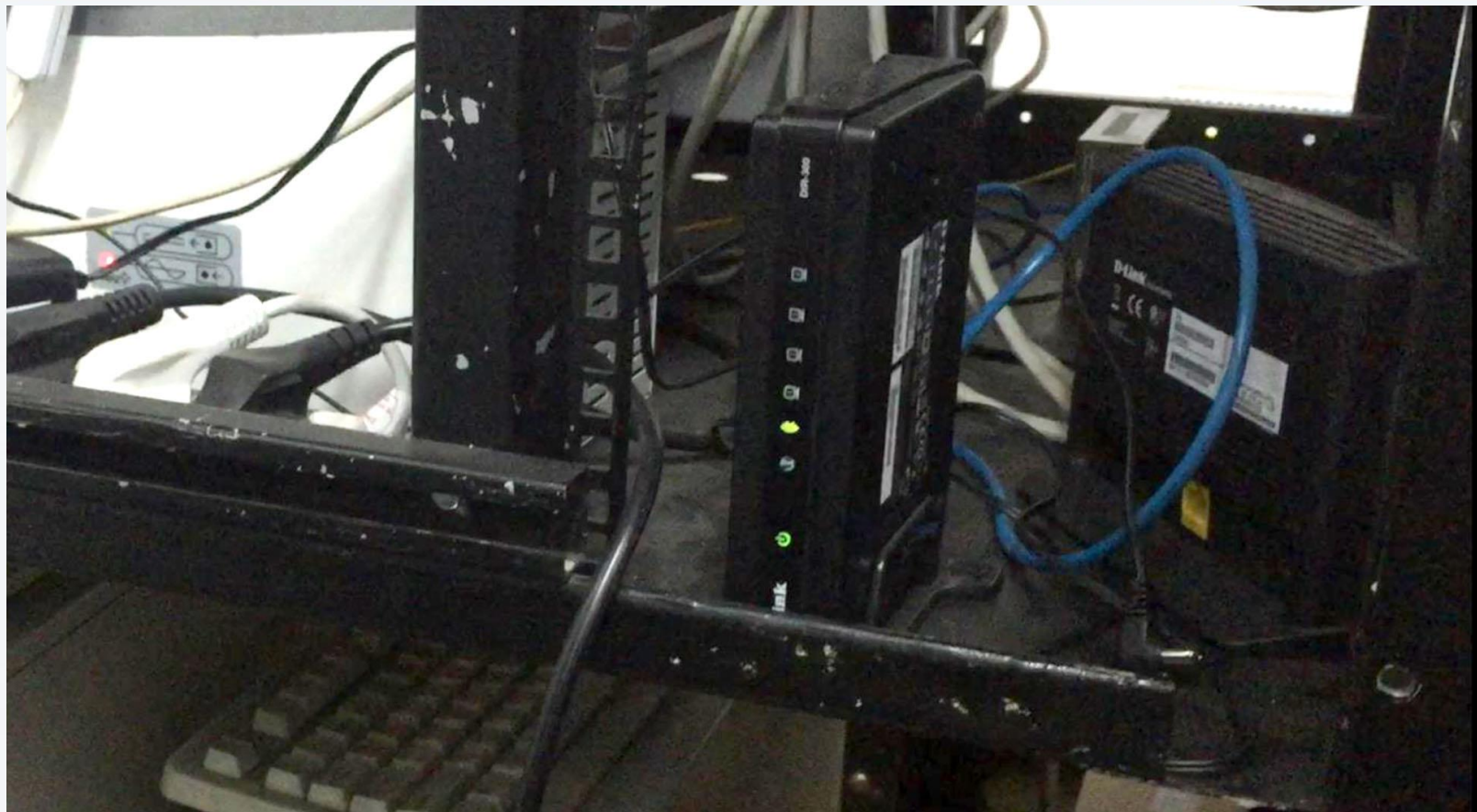
Serwerownie utrzymane w pokoju bez przygotowanego odpowiedniego środowiska
