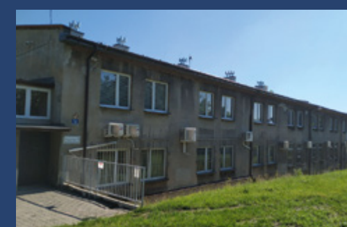
Budynek Urzędu Pracy przed rozpoczęciem termomodernizacji
