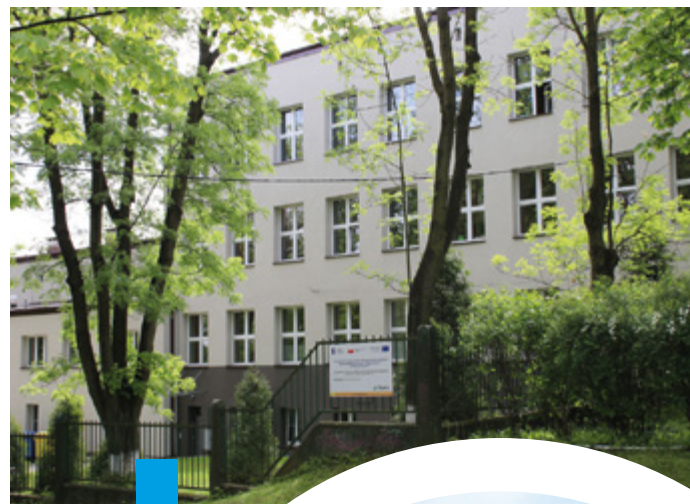
Nowa elewacja MSP nr 2
