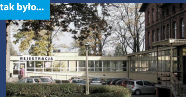
Stary szpital przed rozpoczęciem przebudowy
