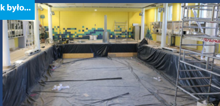
Basen w MSP nr 5 w trakcie remontu
