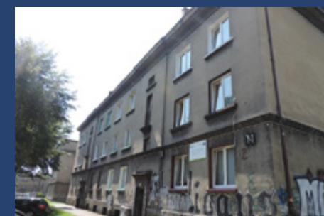
Budynek na os. Wiczorka przed termomodernizacją
