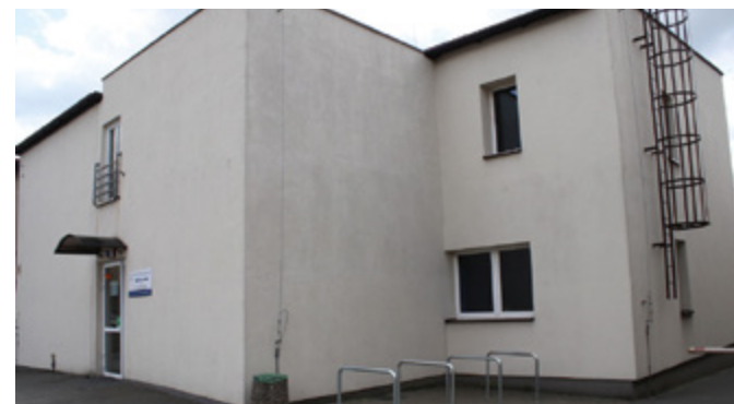
Odrementowana elewacja CUS przy ul. Żwirki
