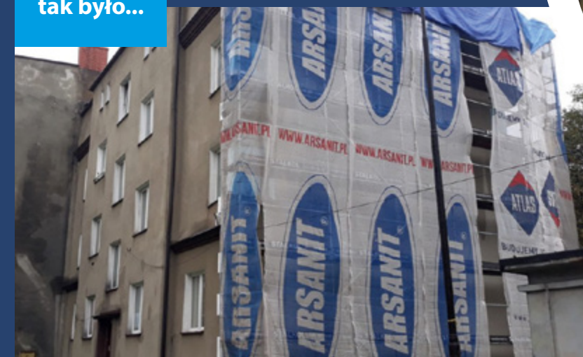
Budynek przy ul. Hutniczej przed termomodernizacją
