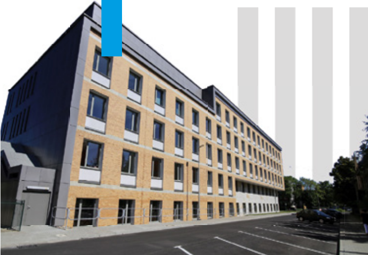
Nowy budynek od strony ul. Kościuszki
