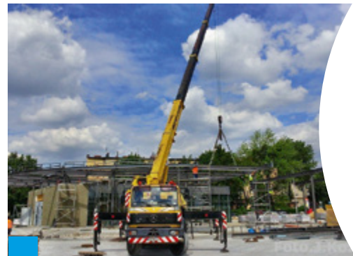
Prace przy powstaniu nowoczesnego dworca
