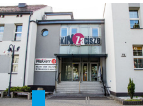
Budynek kina po remoncie
