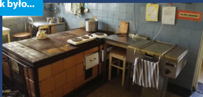
Kuchnia w Przedszkolu nr 7 przed remontem
