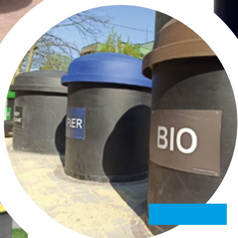
Pojemniki półpodziemne przy ul. Janty
