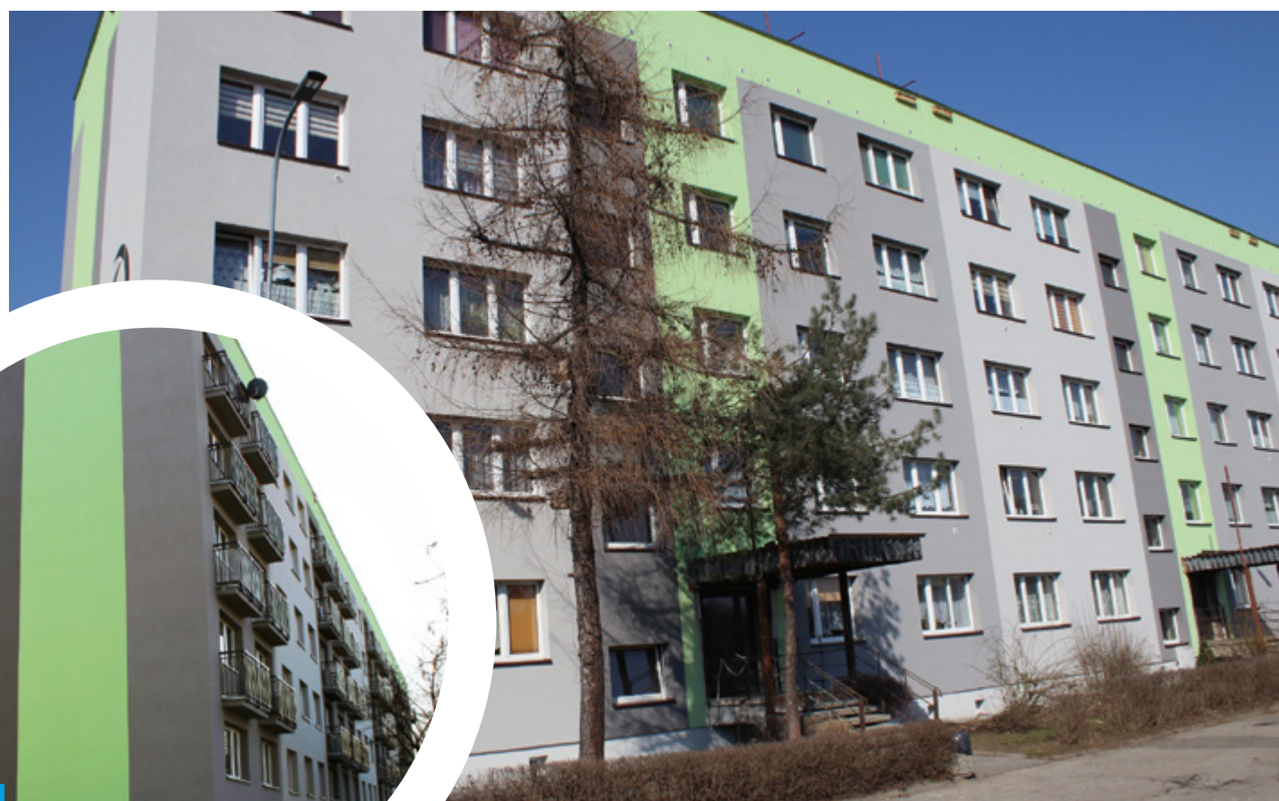
Termomodernizacja wpływa na energochłonność budynku
