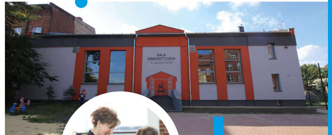
Sala po gruntownej przebudowie
