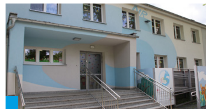
Przedszkole nr 5 z nową elewacją po remoncie
