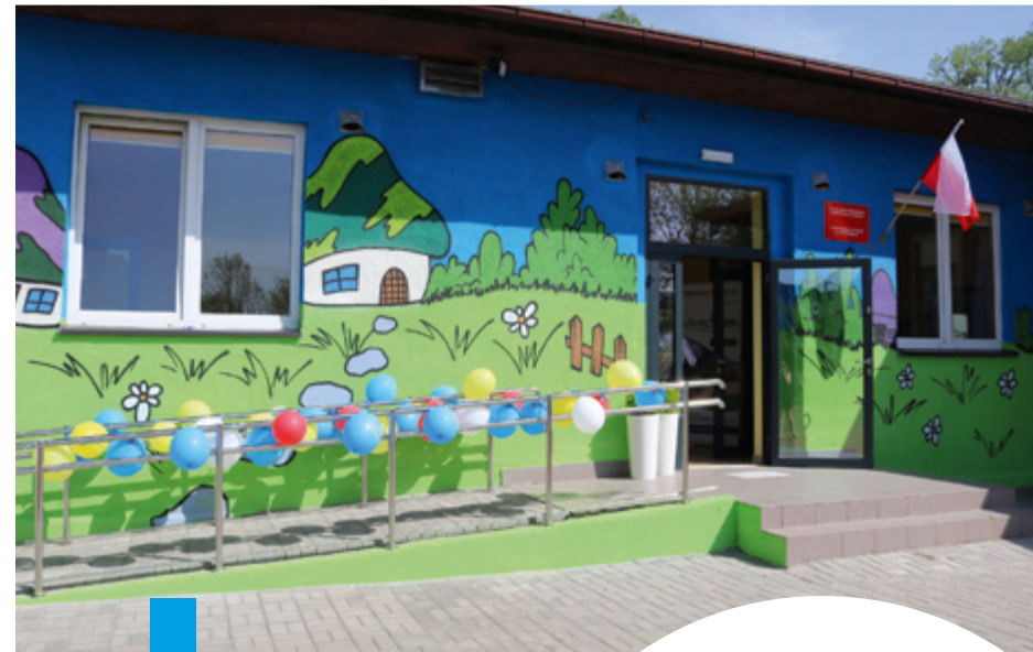
Żłobek Miejski przy ul. Bytomskiej po remoncie
