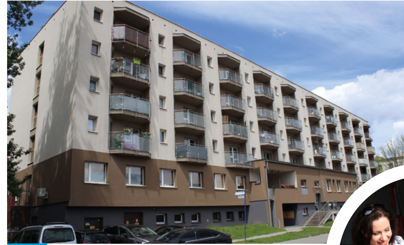
Ziętka 60 po kompleksowej przebudowie
