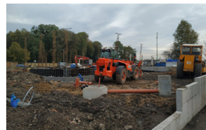
Pierwsze prace przy budowie restauracji McDonald's
