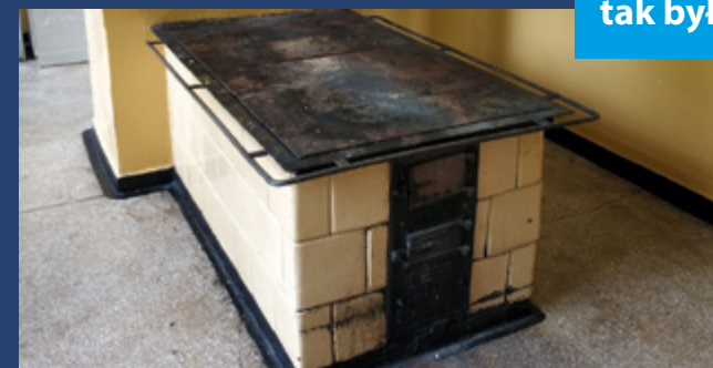
Kuchnia w Przedszkolu nr 13 przed remontem
