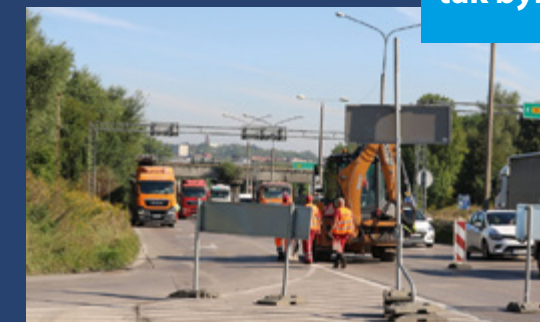
Remont nawierzchni DW 911
