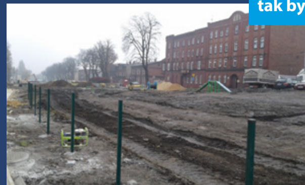
Rozpoczęcie prac przy budowie wybiegu przy ul. Janty
