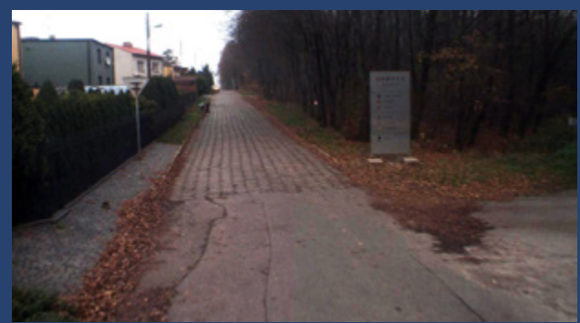
Ul. Ceramiki przed remontem
