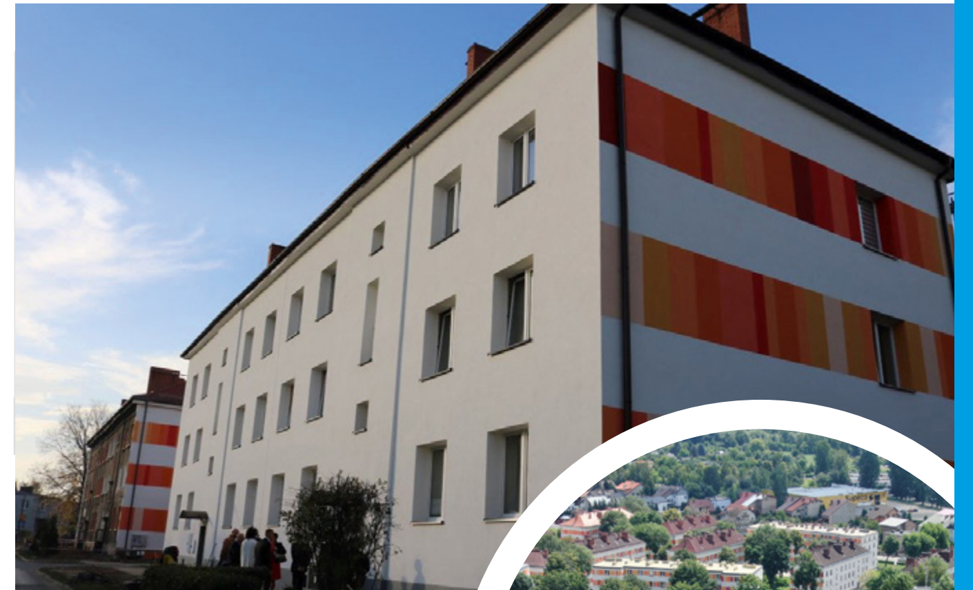
Pierwsze efekty prac remontowych
