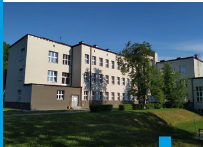
Termomodernizacja MSP nr 2 wpłynęła na energochłonność budynku
