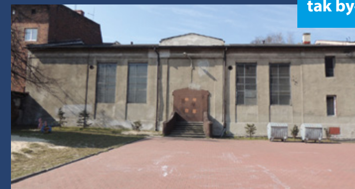
Wygląd hali przed rozpoczęciem remontu
