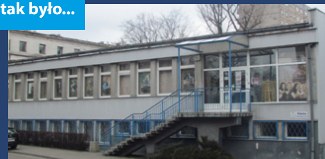
Budynek biblioteki przed rozpoczęciem remontu
