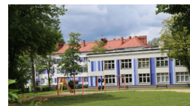
Przedszkole nr 7 wkomponowane w zieleni i dostosowane do kolorystyki osiedla
